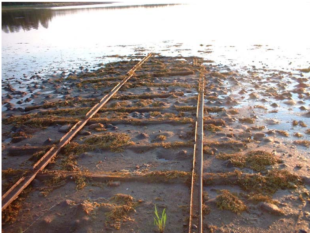
Фото № 1. Железнодорожная ветка в море для лесосплава. Обнаружена в Сосновой губе в 2004 году, в 1,5 км от Савватьевского скита. Фото 2005 г.
