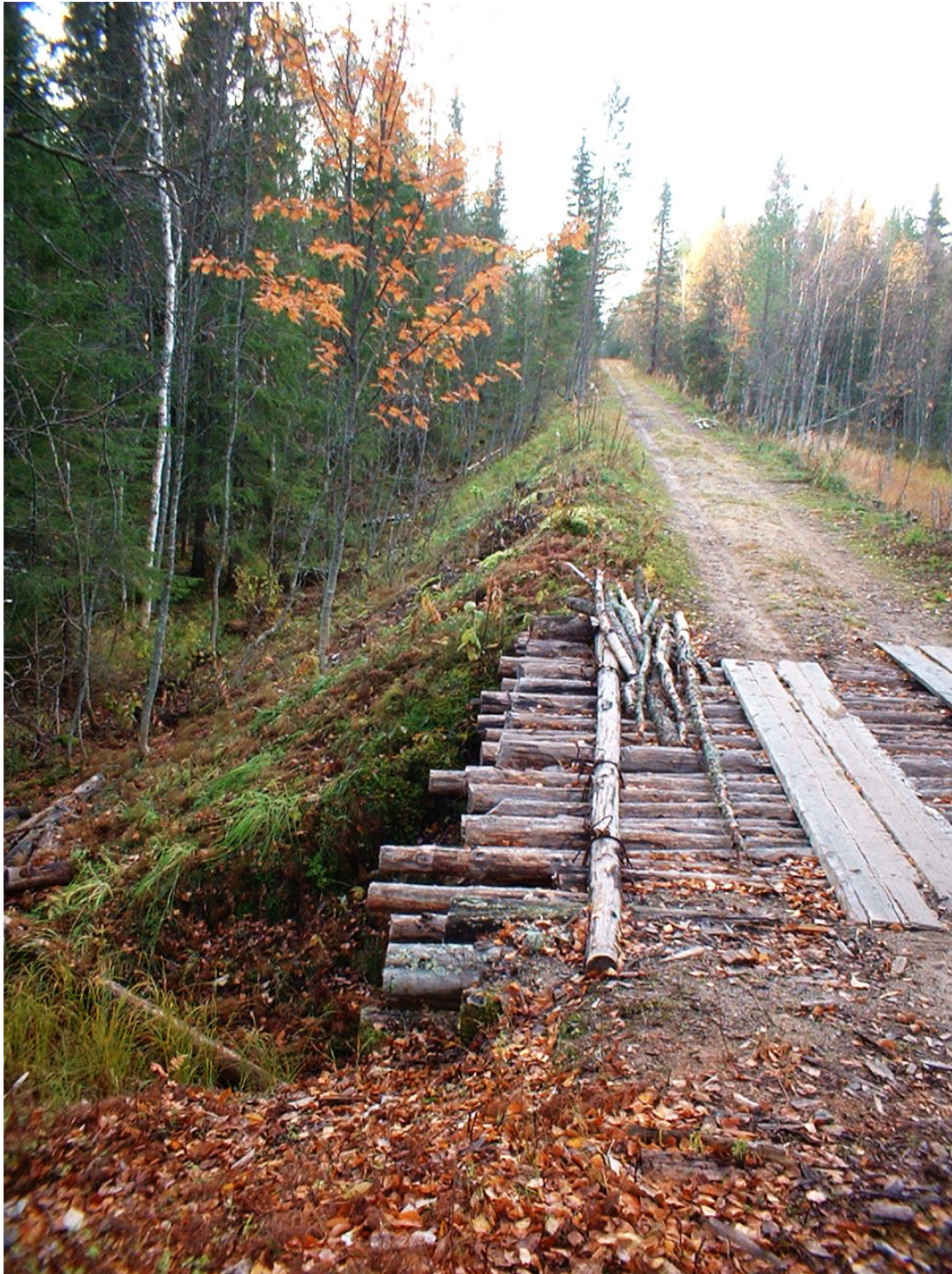
Фото № 5. Насыпь Филимоновской ветки с деревянным мостом через ручей у оз. Окунево. Фото 2004 г.
